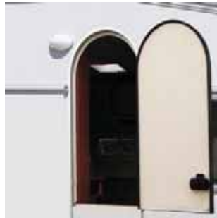
Portes « écurie » Porte avec face intérieure lisse et ouverture au milieu.
