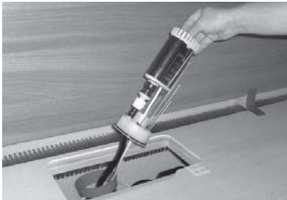
Wasserpumpe vollständig entleeren. Dazu die Pumpe so halten, dass das Wasser aus dem Entleerungsventil des Kaltwasser-Schlauches laufen kann.
