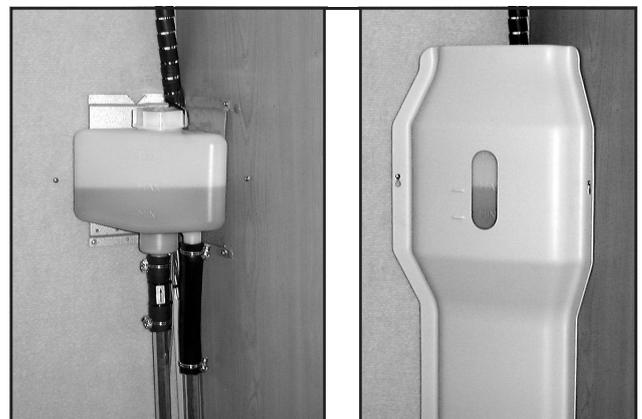
Ausdehngefäß und Deckplatte mit Schauglas.
