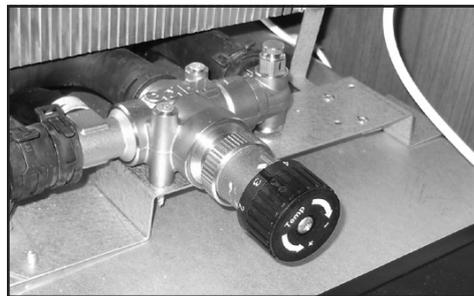
Man kann AGS II Pro am Shuntventil am Heizkessel erkennen.
