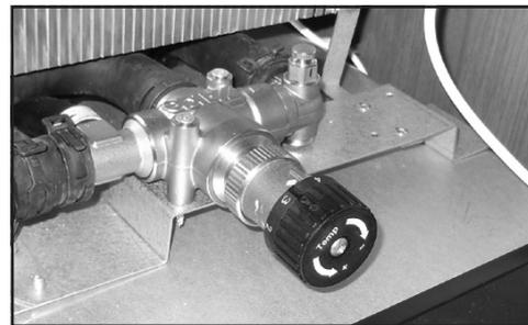
Man kann AGS II Pro am Shuntventil am Heizkessel erkennen.
