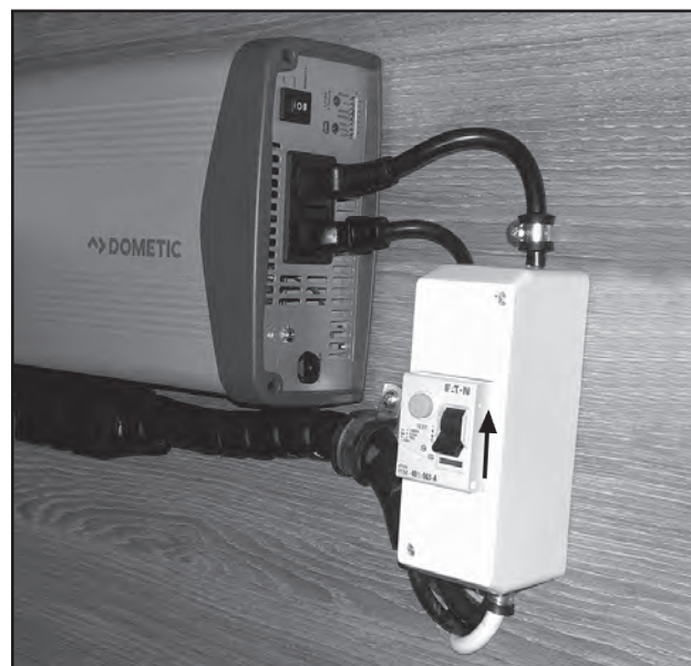
En jordfeilbryter er montert ved inverteren.
