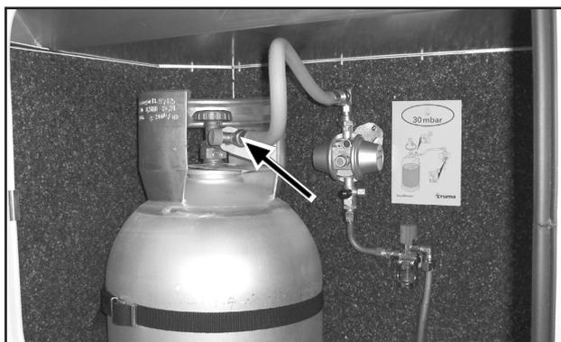
Knopf drücken, sodass das Schlauchbruchventil öffnet.
