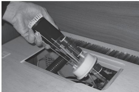
Wasserpumpe vollständig entleeren. Dazu die Pumpe so halten, dass das Wasser aus dem Entleerungsventil des Kaltwasser-Schlauches laufen kann.
