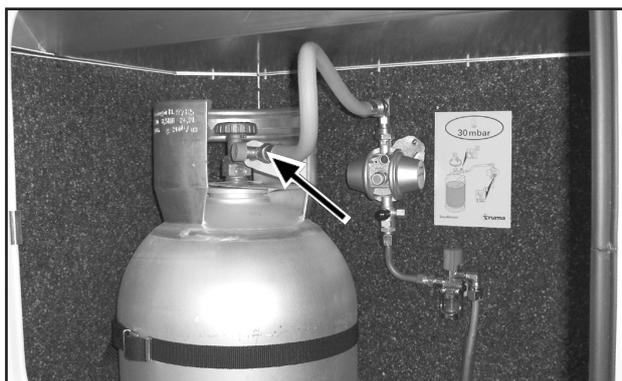
Knopf drücken, sodass das Schlauchbruchventil öffnet.
