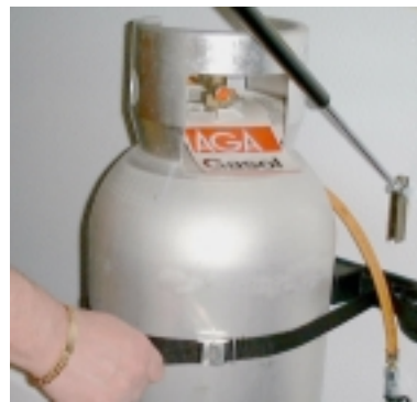
Kontroller at gassflasken er ordentlig festet.
