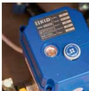
Elektrische Entleerung des Wassersystems
