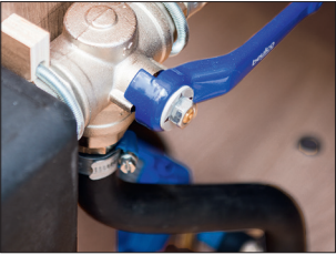
Direkte afløb; forbikobling spilde-vandtank (standard Imperial)
