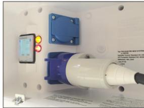
Stromzähler im Schaltkasten
