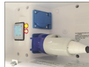
Kilowattmeter in elektriciteitskast
