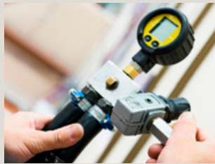
GASSYSTEEM. Het flessengassysteem wordt onder druk getest.
