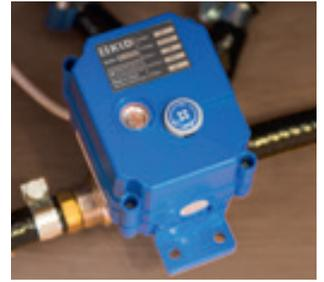
Elektrische Entleerung des Abflusses
