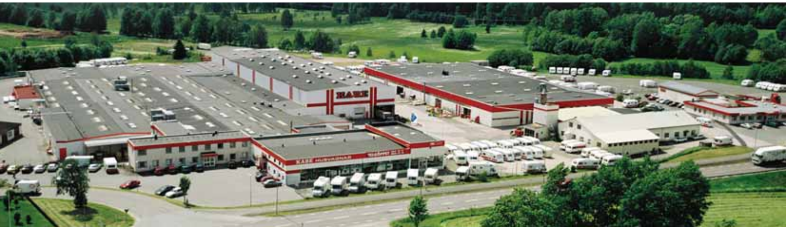
Fabrik i Tenhult för tillverkning av husvagnar, 28.000 m 2
