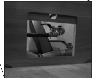
Kranen van de verswatertank: Overvulbeveiliging 45 liter respectievelijk aftappen bij het legen van de verswatertank.
