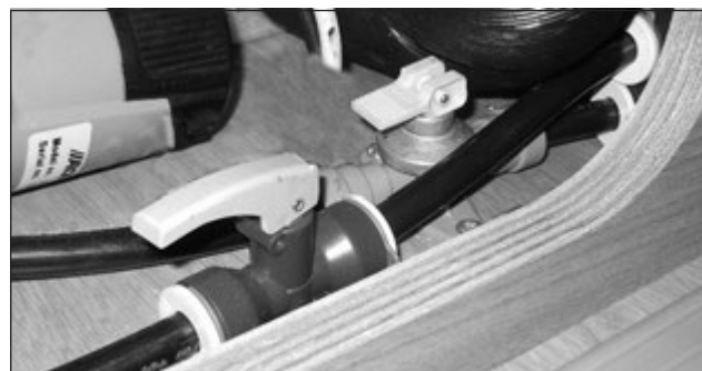
Aftapkranen voor koud- en warmwaterslangen
