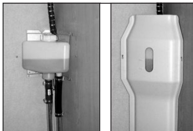
Ausdehngefäß und Blende mit Schauglas.
