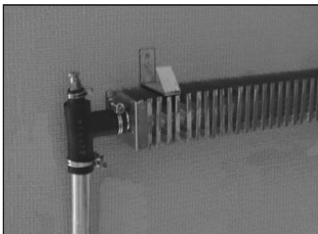
Konvektionsheizkörper und Schlauchanschluss mit Entlüftungsnippel.
