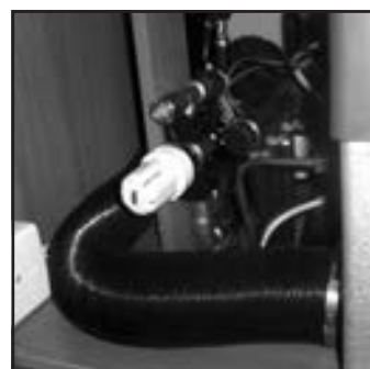
Shunt-Ventil für die Fußbodenheizung (nur bestimmte Modelle).
