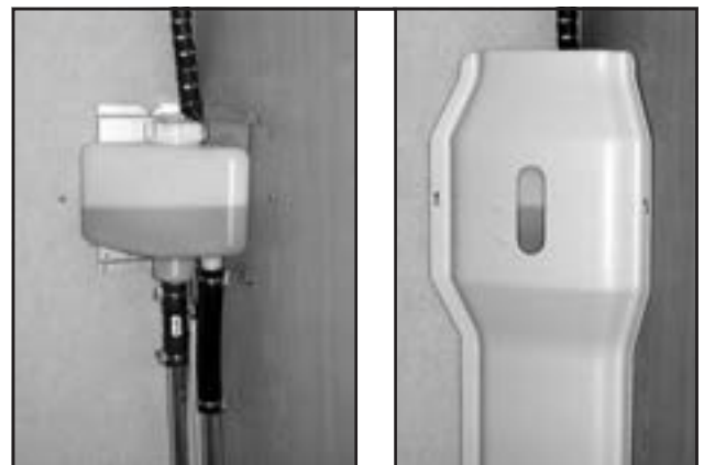
Ausdehngefäß und Blende mit Schauglas.
