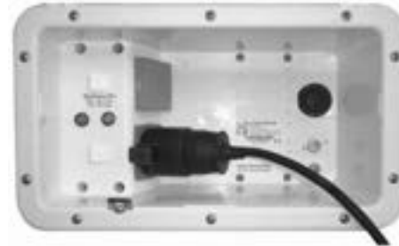
Außenseite des Schaltkastens
