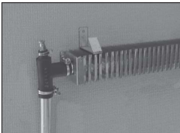
Konvektor och slanganslutning med luftningsnippel.
