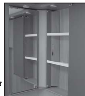
Inspektionshålet placerat i badrumskåpet.
