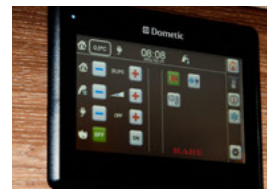
Meldungen und Steuermöglichkeiten für das Heizungssystem werden auf einer eigenen Seite angezeigt. Hier können Sie mit dem digitalen Schieberegler leicht die Temperatur erhöhen oder senken.
