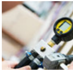
Das Gassystem wird Drucktests unterzogen.
