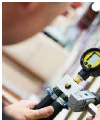
Kaasujärjestelmälle tehdään painekoe.
