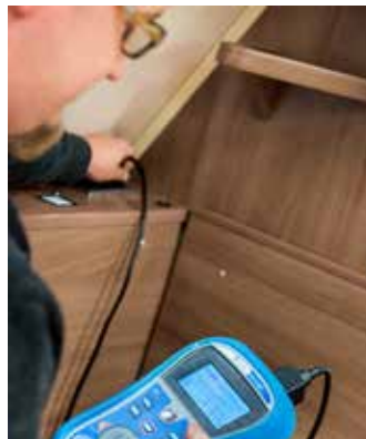
Sähköjärjestelmät ja muut tärkeät toiminnot tarkastetaan, ennen kuin matkailuvaunut ja -autot toimitetaan tehtaalta.
