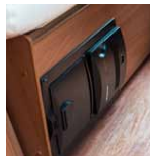
CENTRALE STOFZUIGIN- STALLATIE Y0349
