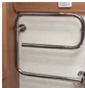
HANDDOEKDROGER ELEKTRISCH MET TIMER MET WATERCIRCUIT WATERCIRCUIT IN DE CABINE
