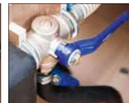
Direktavlopp; förbikoppling grävattentank
