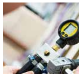
Gassysteem. Het flessengas-systeem wordt onder druk getest.
