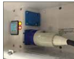
Kilowattmeter in elektriciteits kast
