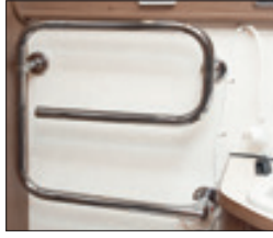
Handdoekdroger elektrisch verwarmt (X0260)
