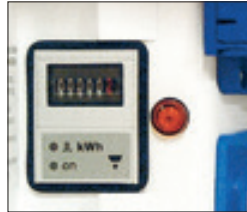
Kilowattmeter in elektriciteits kast
