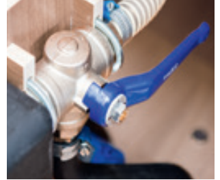
Directe afvoer afvalwater
