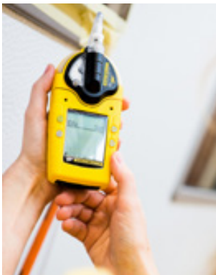
Det er livsvigtigt, at ventilationen fungerer som den skal, og dette kontrolleres nøje.
