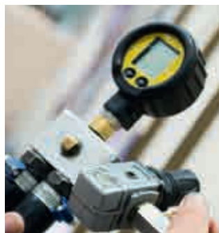
Kaasujärjestelmälle tehdään painekoe.
