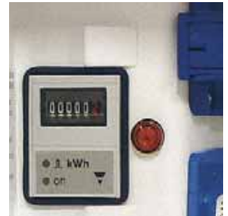
Ampèremeter Vast gemonteerd in de elektriciteits-kast. Verlichting (X0255) in de elektriciteits-kast.
