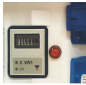
Ampèremeter Vast gemonteerd in de elektriciteitscentrale.
