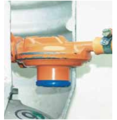
Vänd reduceringsventilen med luftningshålet nedåt.
