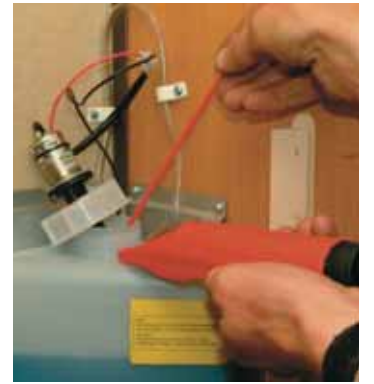
Kontrollera frostskyddet i värmesystemet, och komplettera vid behov.
