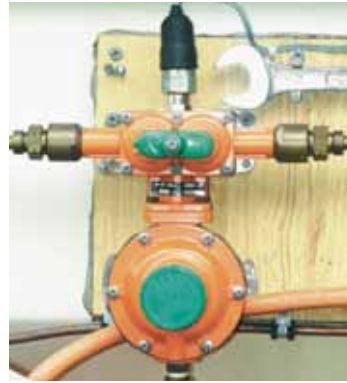
En automatisk gasolomkopplare kan vara en vettig investering, som du har glädje av året runt.
