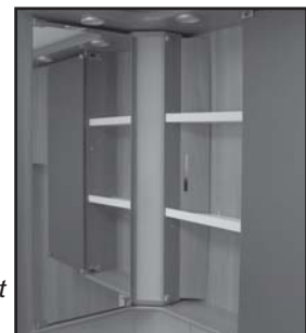
Inspektionshålet placerat i badrumskåpet.
