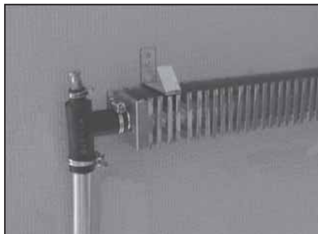
Konvektor och slanganslutning med luftningsnippl.
