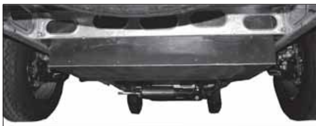
Gråvattentanken monterad mellan husbilens bakhjul.
