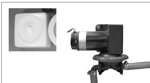
Gråvattentankens tömningspump och dess strömbrytare.
