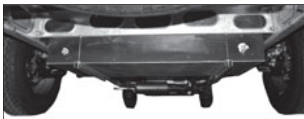
Gråvattentanken monterad mellan husbilens bakhjul.
