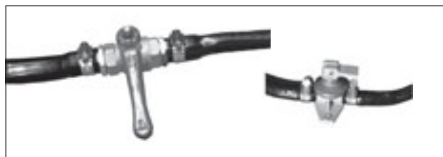
Vattensystemets avtappningskran för färskvatten resp avtappningsventil för varmvattenberedare.
