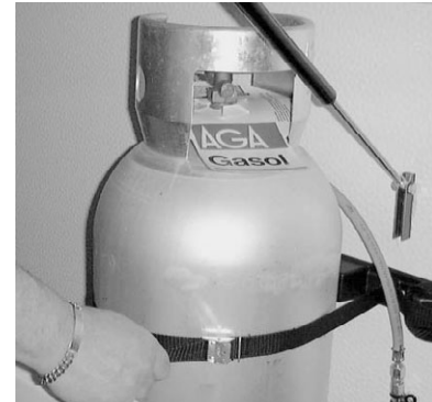
Kontroller at gassflasken er ordentlig festet.
