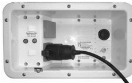
Buitenzijde van de elektriciteitscentrale
