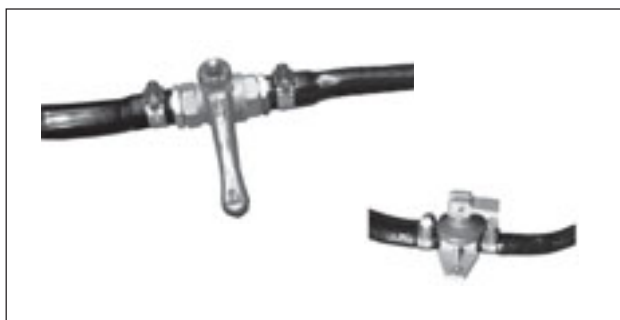
Vesijärjestelmän tuoreveden tyhjennyshana ja lämminvesivaraajan tyhjennysventtiili.
