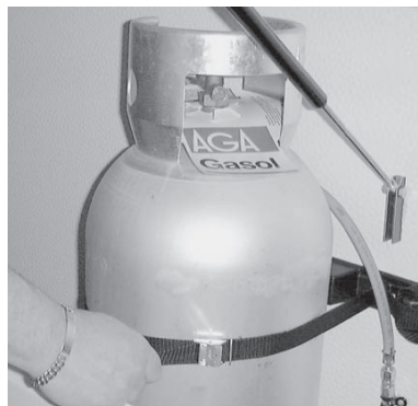
Kontroller at gassflasken er ordentlig festet.
