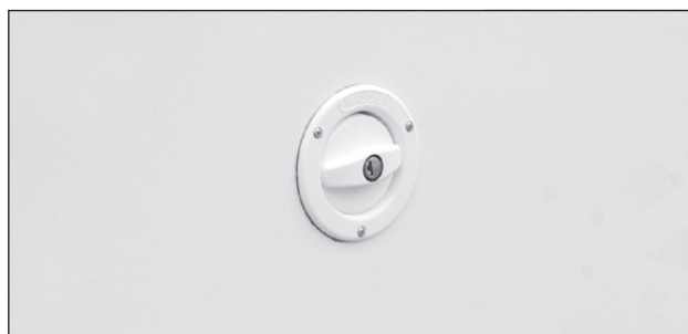
Påfylling av ferskvann.
