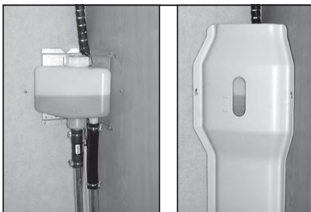
Paisuntasäiliö ja peitelevy tarkastusaukkoineen.
