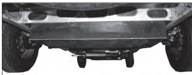
Harmaavesisäiliö on asennettu matkailuauton taka-akselin viereen.
