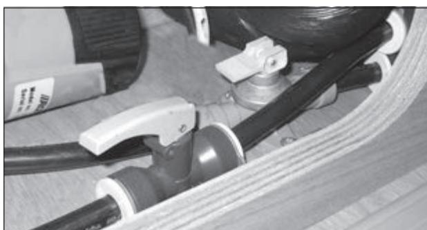
Ablasshähne für Kalt- und Warmwasserschläuche.
