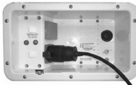
Buitenzijde van de elektriciteitscentrale
