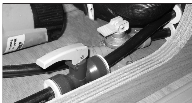
Avtappingskraner for kaldt- og varmtvannsslange.
