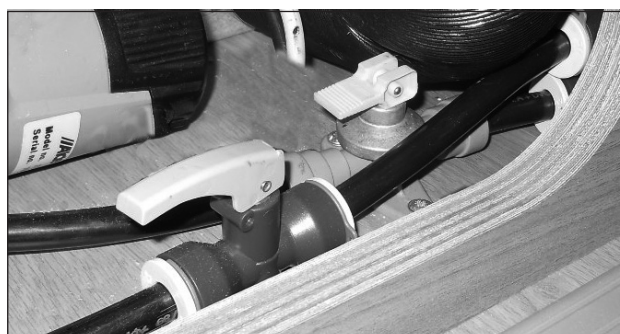
Avtappningskranar för kall- och varmvattenslang.
