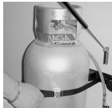
Kontroller at gassflasken er ordentlig festet.
