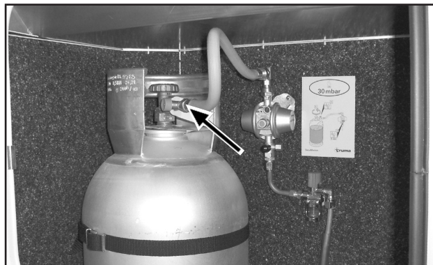
Avaa letkunrikkovoventtiilit painamalla painiketta. Jos letkunrikkovoventtiili on kiinni, ei kaasulaitteita voi sytyttää.
