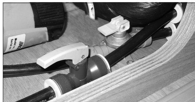
Ablasshähne für Kalt- und Warmwasserschläuche.
