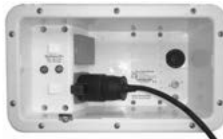
Buitenzijde van de elektriciteitscentrale
