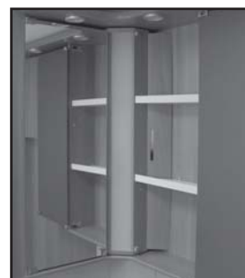
Tarkastusreiä kylpyhuoneen kaapissa.
